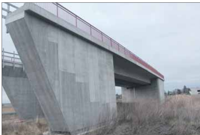
Auch Bauwerke wie diese Brücke an der »OU« Heldenbergen werden nach Fertigstellung der »OU Altenstadt« das Bild vom »liebenswertem Altenstadt« prägen.
