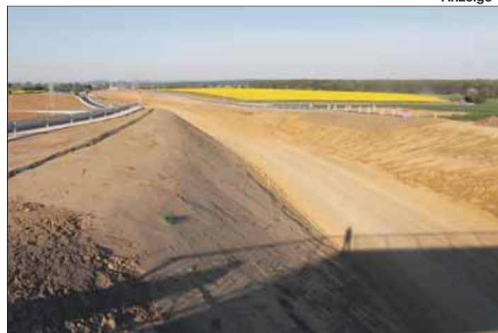
Anhand dieser Erdbewegungen der Umgehungsstraße Heldenbergen den Begriff »gefräst« in der Bauamtsdokumentation zu hinterfragen, ist schon ein starkes Stück.
